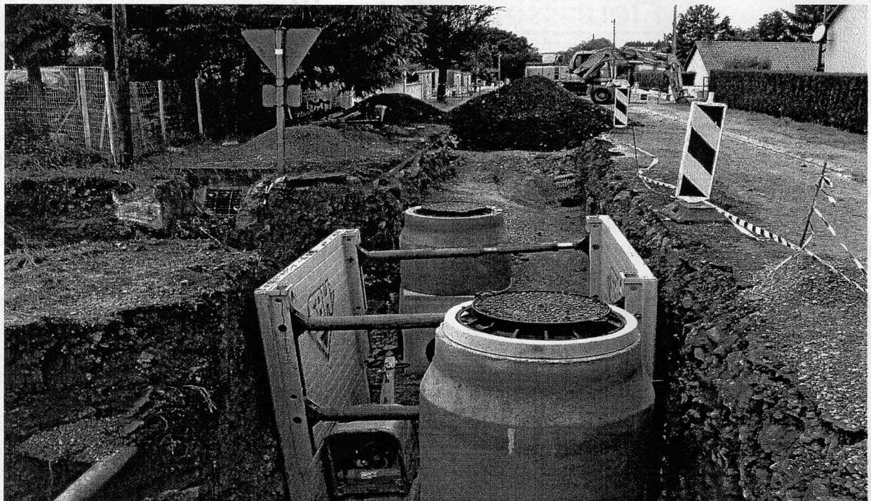
Raccordement au réseau d'assainissement du futur lotissement "le clos de Chantrenne"
