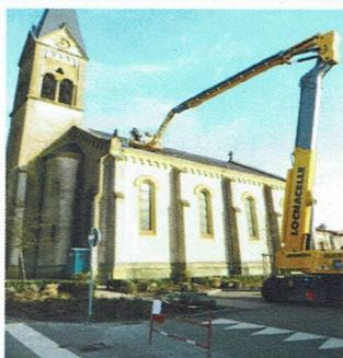
Préalablement aux travaux de ravalement des peintures de l'intérieur de l'église, il a été nécessaire de procéder à des travaux d'étanchéité.
