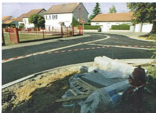
C'est à ce titre que des travaux de réfection de chaussée ont été entrepris rue de l'Abbé Lauvray. L'entreprise COLAS de Marly à laquelle le marché de travaux a été confié par la Métropole a procédé au renouvellement des enrobés de la chaussée, changé les bordures qui le nécessitaient et rendu la voie accessible aux personnes à mobilité réduite par des aménagements spécifiques.
